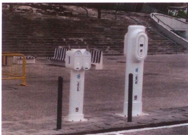
Figura 13 – Ponto de carregamento eléctrico
