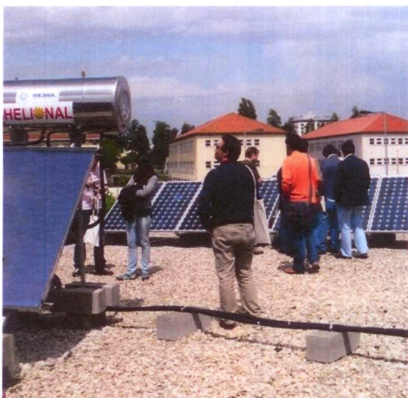
Figura 4 – Tour Solar no edifício sede da Gebalis, Maio 200
